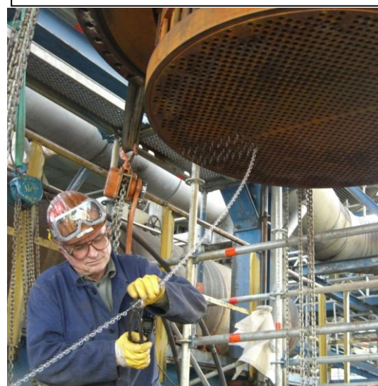
フィード/エフルエント熱交換器への結合 hiTRAN 立体素子の取り付け
