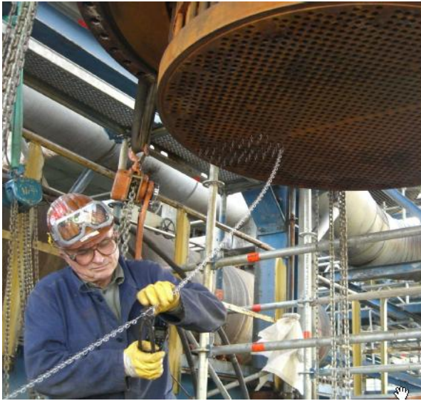
図 7 熱交換器管側への hiTRAN 挿入工事
